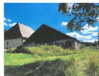
Bâti agricole identifié sur la parcelle ZL 50. Photographie.
