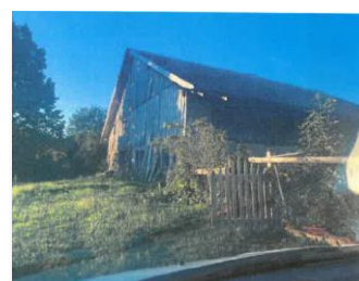
Bâti agricole identifié sur la parcelle ZC 3. Photographie.
